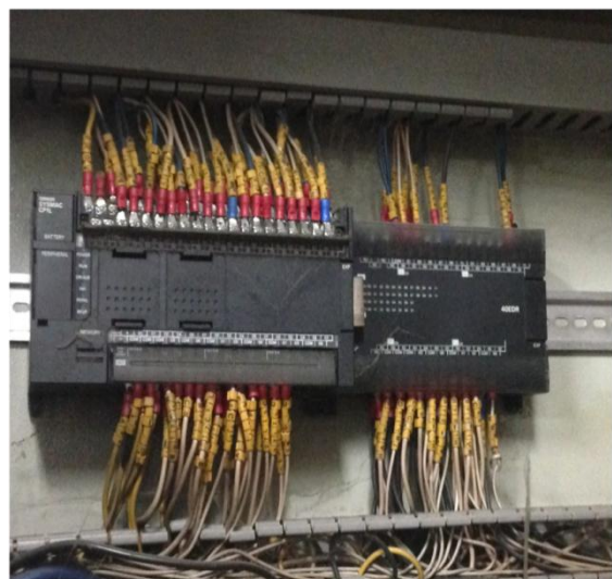
รูปที่ 3 การติดตั้ง PLC
